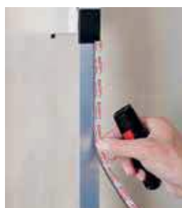
Paso 3: Colocar la cinta Foam Tape
