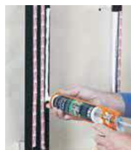
Paso 4: Aplicar el adhesivo
