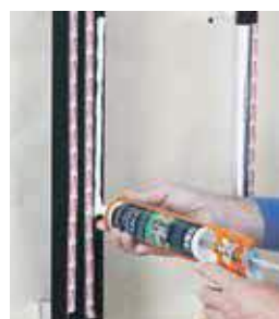
Paso 4: Aplicar el adhesivo
