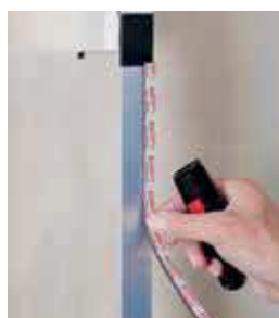
Paso 3: Colocar la cinta Foam Tape
