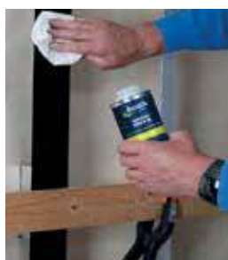
Paso 1: Limpiar / imprimir el rastrel
