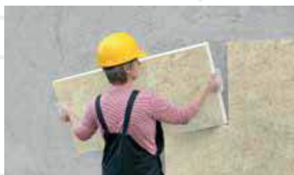
Pegado de paneles pesados
